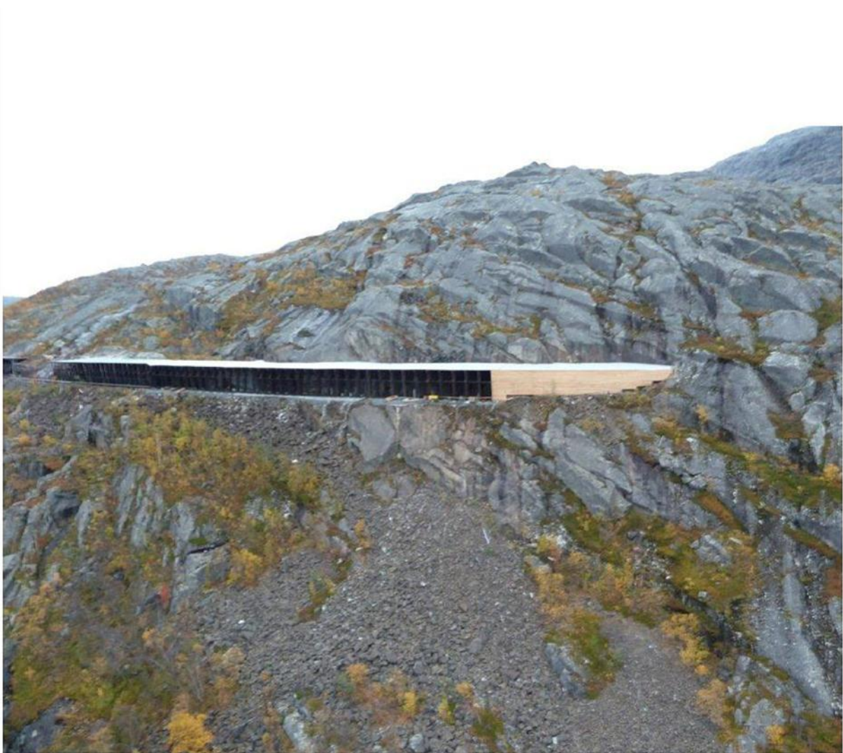
Snøoverbygg på Ofotbanen.
