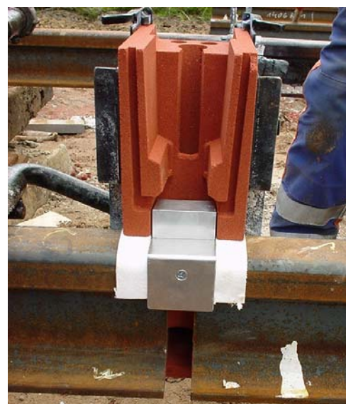
Keramiske remser klebes på skinnehodet
