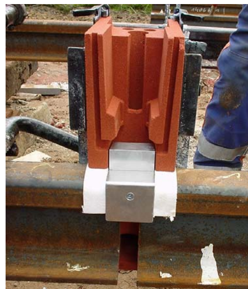
Keramiske remser klebes på skinnehodet
